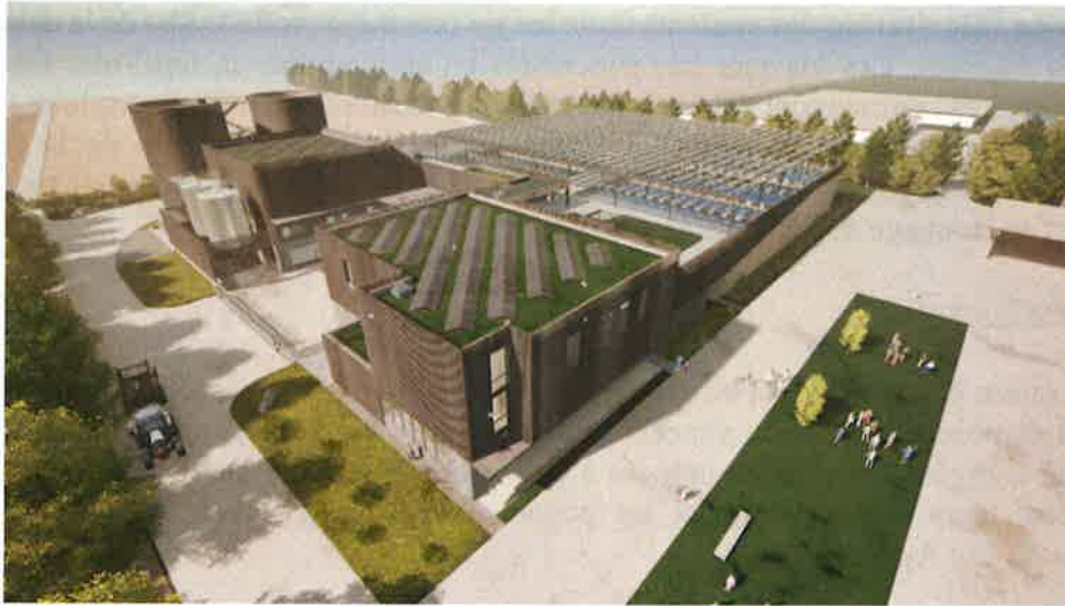
Figure 4 – Vue sur l'ensemble de la STEP avec le bardage métallique recouvrant le bâtiment administratif (en bas au centre) et le bâtiment de la file boue (en-haut à gauche) et s'étendant sur les bassins de traitement (en-haut à droite)
